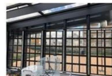
後付け工法による光発電ガラスの試作設置例
