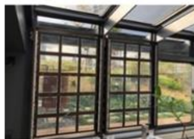
後付け工法による光発電ガラスの試作設置例
